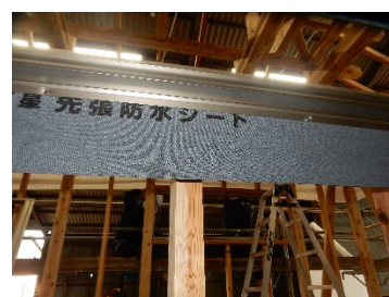
JWMA-A01 規格品施工状況
