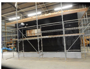
ARK14W 規格品施工状況
