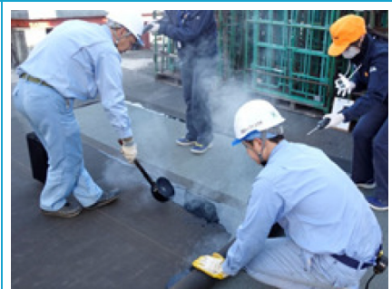
溶融アスファルトの散布&ルーフィングの貼付作業
