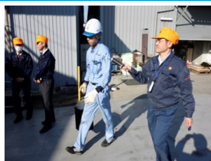
アスファルト運搬作業
