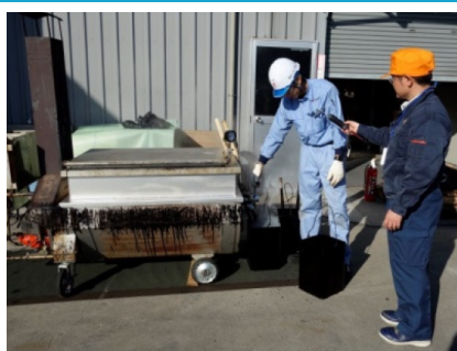
アスファルト溶解釜周辺
