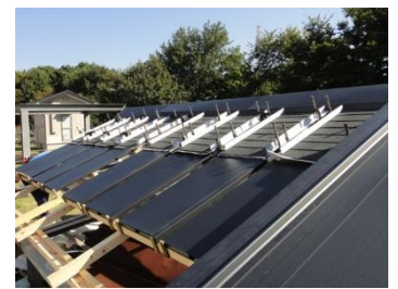
写真2 試験体の暴露状況
