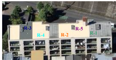
写真1 集合住宅屋上の状況
