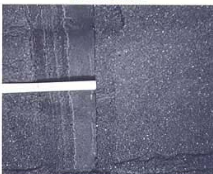
接合部の収縮すれ
