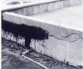
立上がり保護層の倒壊、笠木のひび割れ
