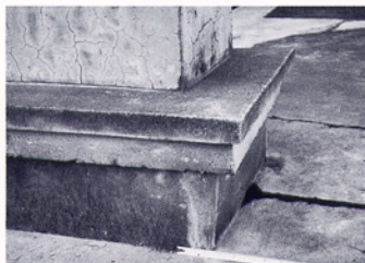
保護層の破損
