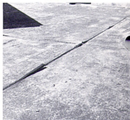
立上がり保護層の倒壊、笠木のひび割れ
