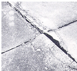
立上がり保護層のひび割れ
