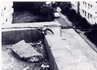
砂利の移動(防水層の露出)
