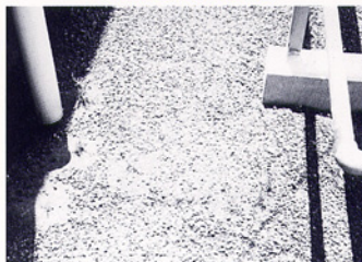
砂利の移動(防水層の露出)
