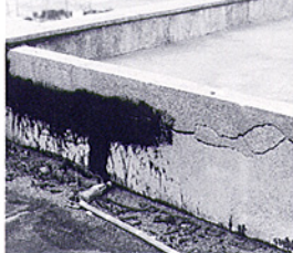
立上がり保護層のひび割れ
