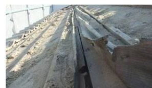
図11 下葺き材の収縮
