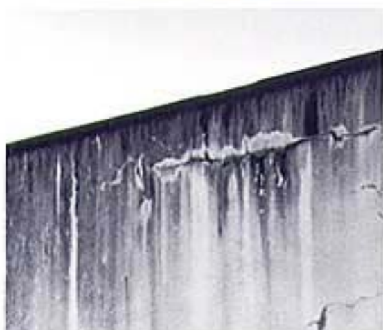
パラベットの押出し
